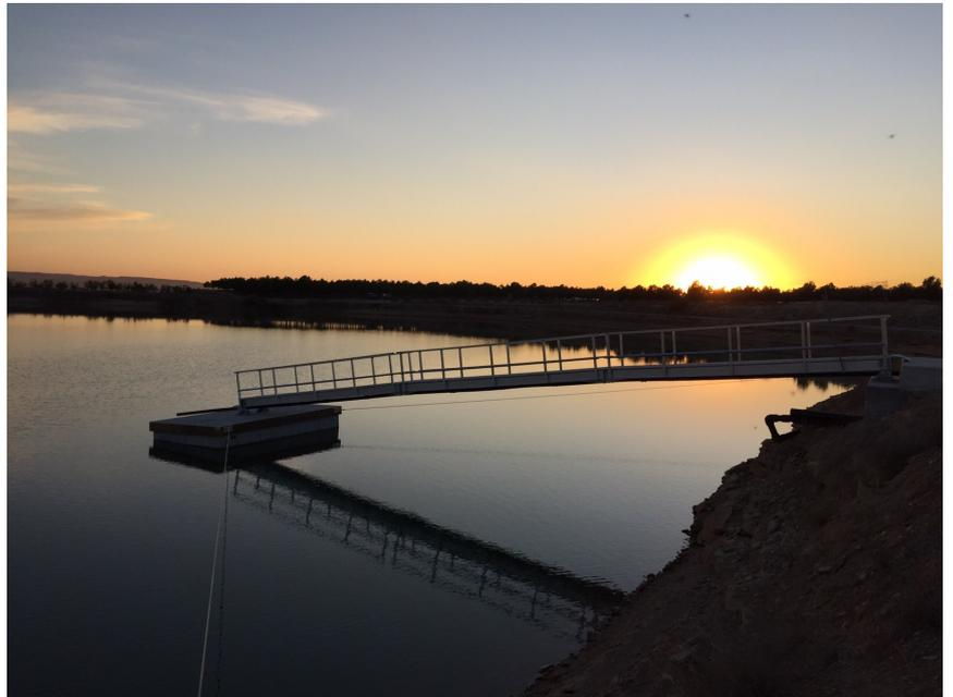
Construcciones Metálicas Ferrer, ha diseñado, construido e instalado un pantalán flotante de hormigón Unifloat® de 6x3m y una pasarela de 20m de acero galvanizado en caliente para la planta potabilizadora de Miralcamp (Lleida) para la extracción y captación de agua.
